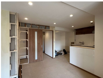
【ダイニング】★工事中
